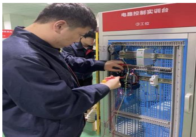
图 3 电气控制系统装调模块试题考核
